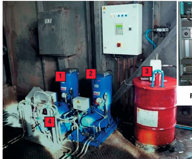
Рис. 4 Поддача смазки типа «Графитная»:
