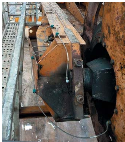
Рис. 1 Смазка подшипников скольжения и качения опоры головных блоков
